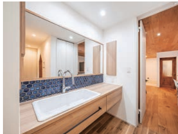
洗面台は吊りにし、足元を開放させることで、湿気のコもりを解消。シンプルな空間のアクセントは、ブルーのヘキサゴンタイル
